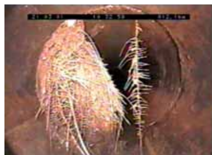
Ryc. 2. Przerost korzeni drzew z nieszczelnego złącza z boku kanału i z obszaru wierzchołka, fot. autor
